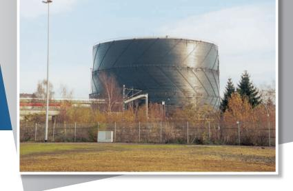
Bei einem Störfall am Gasometer kann es zur Freisetzung von Koksgas kommen. Koksgas besteht aus einem Gasgemisch, dessen Hauptbestandteile Wasserstoff ( $H_2$ ), Methan ( $CH_4$ ), Kohlenmonoxid (CO), Stickstoff ( $N_2$ ) und Kohlendioxid ( $CO_2$ ) sind.
